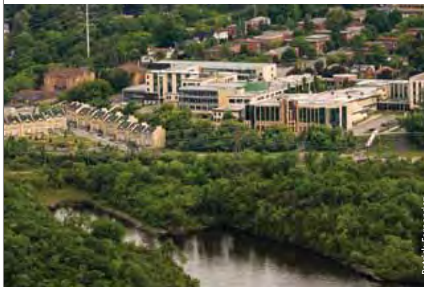
Le pavillon Alexandre-Taché aux abords de la rivière des Outaouais et du magnifique Parc de la Gatineau.
