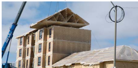
Les résidences de l'UQAT à Rouyn-Noranda en cours de construction.
